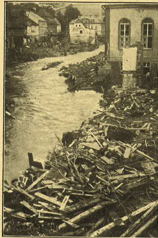
Straße in Berggießhübel nach der Katastrophe
