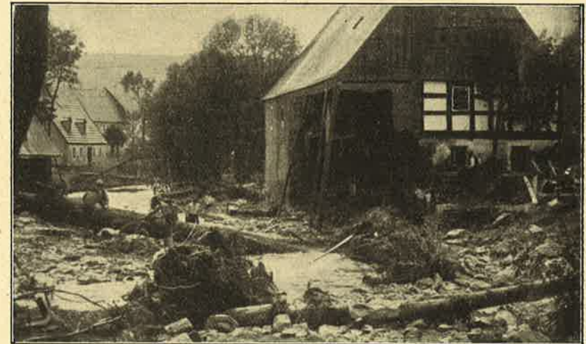
Die Straße in Schönwald 16 Tage nach der Katastrophe Aufgenommen durch die IAH-Hilfskolonne
