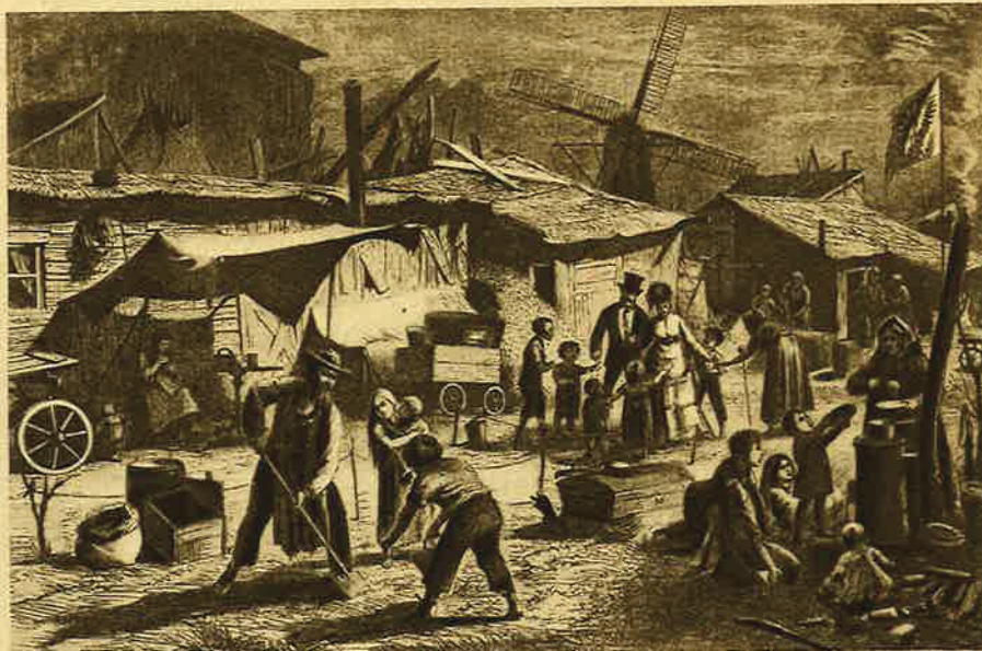
1872 in Berlin: Wohnungsnot. Obdachlose bauen sich Baracken am Kottbuser Damm
